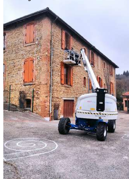
Acrochage des volets rénovés à la mairie
