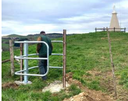
Pose d'une des barrières d'accès à la Madone
